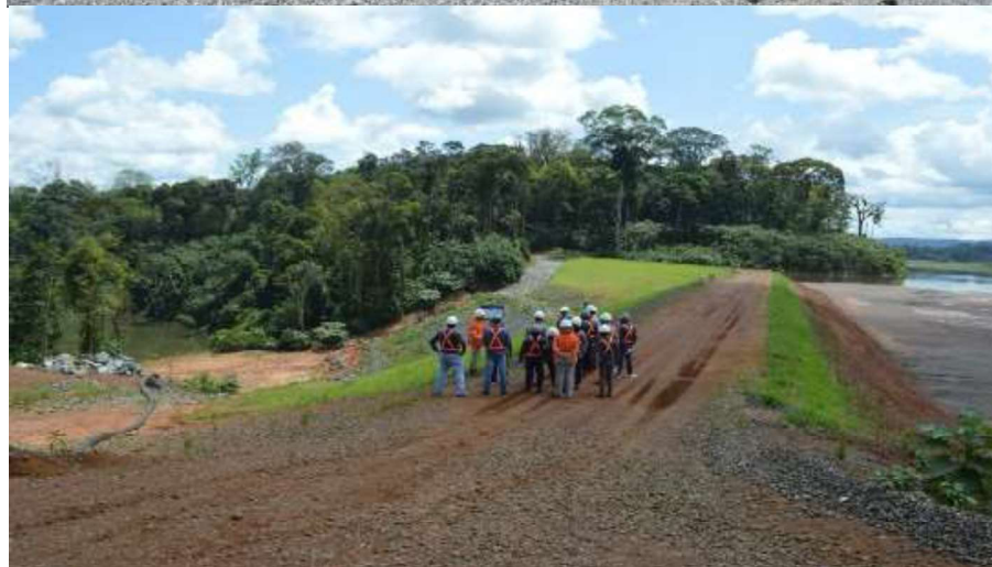
Visita a mina e barragem de rejeitos em Amapá
