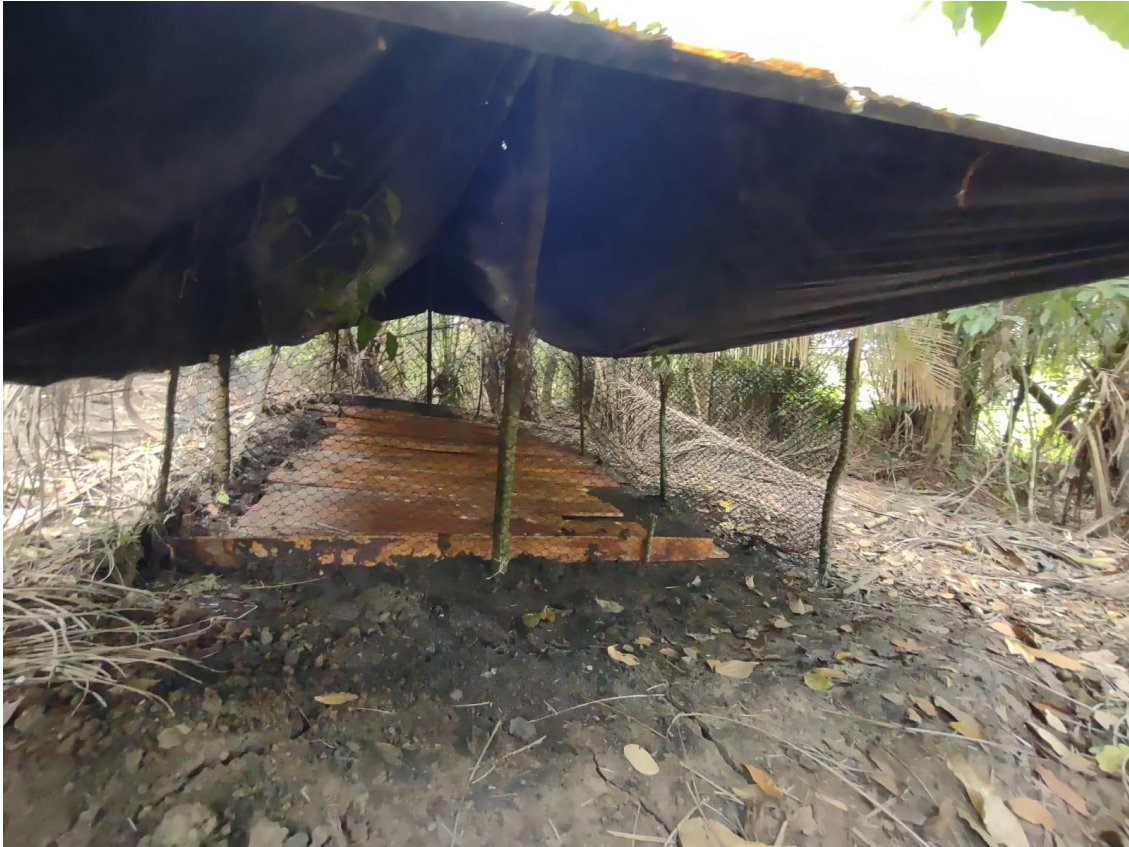
A Lona passa a servir de calha para entrada de água nas frestas dos tapumes.
