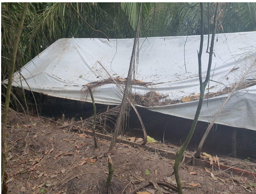
A Lona passa a servir de calha para entrada de água nas frestas dos tapumes.
